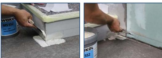
**\* Шаг 2 //** Нанести WAKOL MS 552 Клей для ПВХ и резиновых покрытий при помощи гребенки ТКВ В1 в области внутренних и наружных углов.
