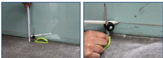
**\* Шаг 1 //** Разметка участков заведения на стену для нанесения клея на стену и пол на высоте 6 см и шириной 6 см.
