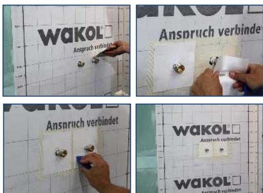
**\* Шаг 8 //** Нанести WAKOL MS 552 Клей для ПВХ и резиновых покрытий в области отверстий для монтажа проводки на стене и оставить не менее чем на 20 минут.
