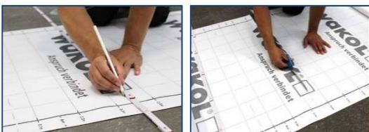
**\* Шаг 4 //** Разметить и отрезать по размеру WAKOL AS 151 Изолирующее покрытие для участка пола и стены.
