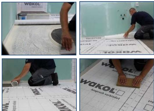
**\* Шаг 6 //** Нанести WAKOL MS 552 Клей для ПВХ и резиновых покрытий при помощи гребенки ТКВ В1 на пол и оставить прим. на 20 минут для увеличения начальной прочности соединения.
