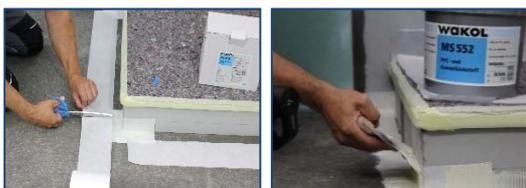
**\* Шаг 3 //** Отрезать WAKOL AS 152 Изолирующая лента нужной длины; с учетом перекрытия изолирующих углов прим. на 5 см.
