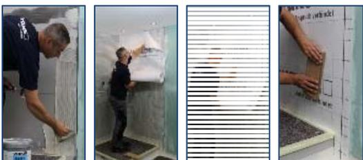
**\* Шаг 5 //** Нанести WAKOL MS 552 Клей для ПВХ и резиновых покрытий при помощи гребенки ТКВ В1 на стену и оставить прим. на 20 минут для увеличения начальной прочности соединения.
